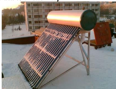
Фигура 9.Схема на вакуумен/топлинен колектор
